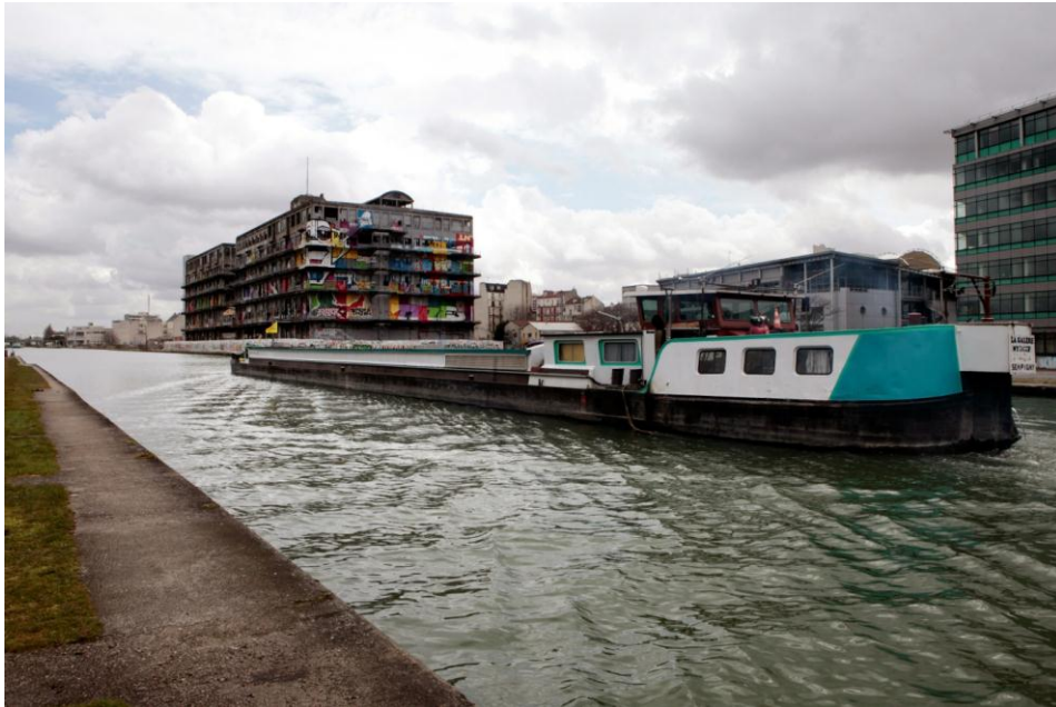
Les Magasins Généraux à Pantin et le Canal de l'Ourcq, source CA Est Ensemble
